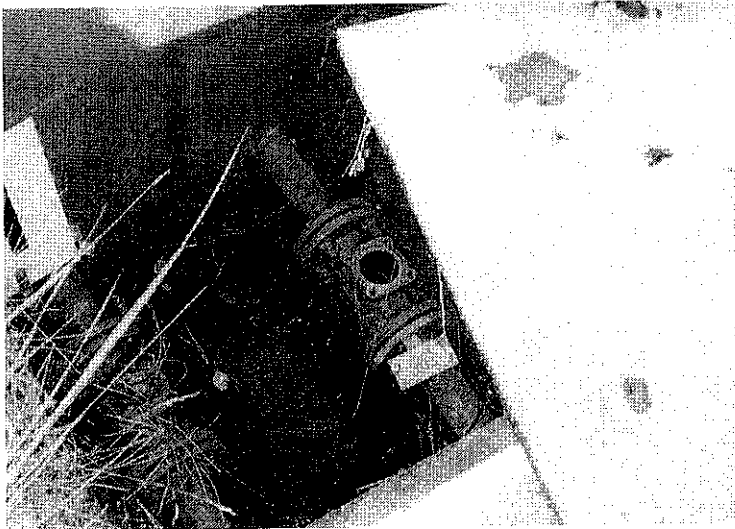
Bild 7 Befüll- bzw. Verteilerschacht 1; Detailaufnahme vom 13.11.01
