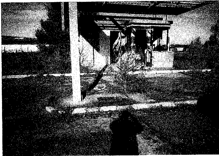
Bild 1: Tankstellengebäude mit Vordach; Stützen des Vordaches stehen auf Tankinsel 1 mit den ehemaligen Zapfsäulen 1 und 2; Aufnahme vom 13.11.01 vor Beginn der Arbeiten
