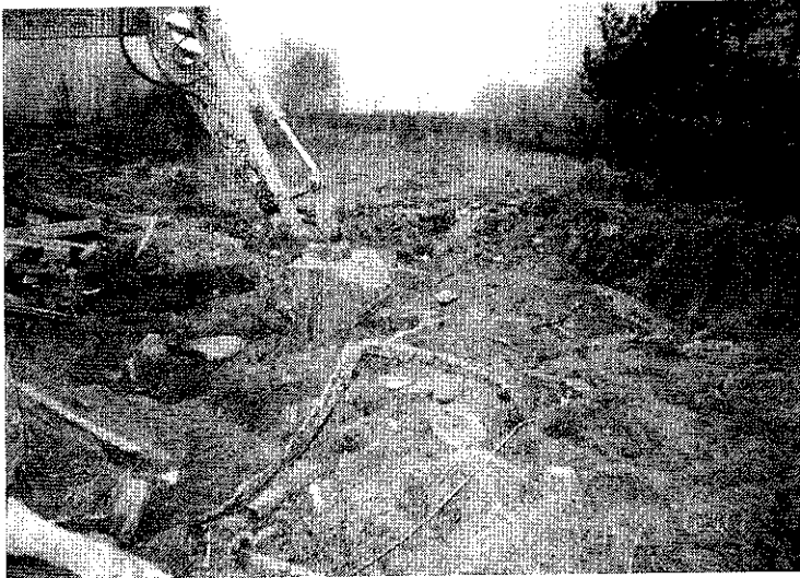
Bild 37 Rückbau der Fundamente Tankstellengebäude am 04.12.01
