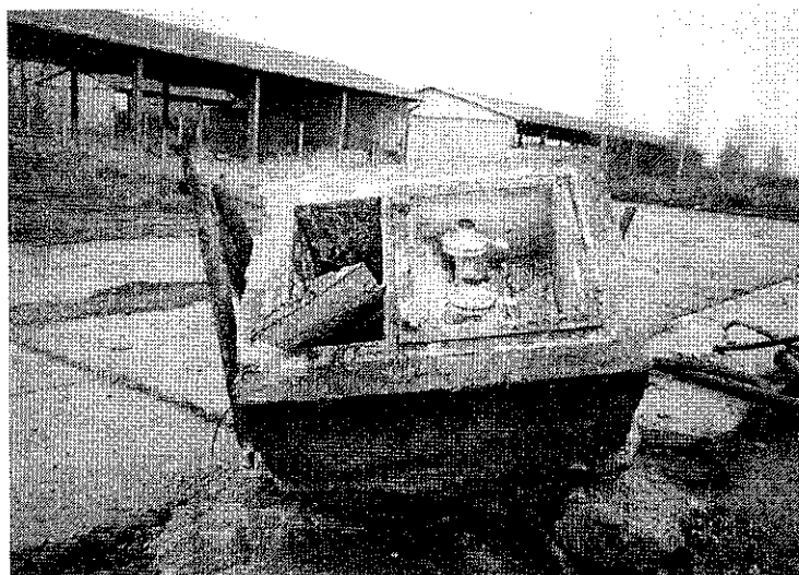
Bild 30 Abfüll- bzw. Verteilerschacht 3 nach dem Rückbau am 28.11.01
