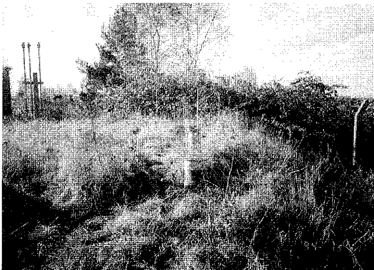
Bild 18 3 Asbestzementrohre Durchmesser 200 mm am nördlichen Rand der Erdtanks; nördlich zur Umzäunung fällt das Gelände steil ab; Aufnahme vom 13.11.01
