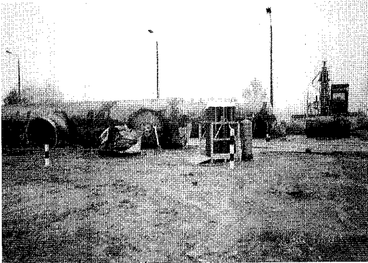
Bild 28 Beginn der Zerlegung der Erdtanks auf dem Brennplatz am 30.11.01
