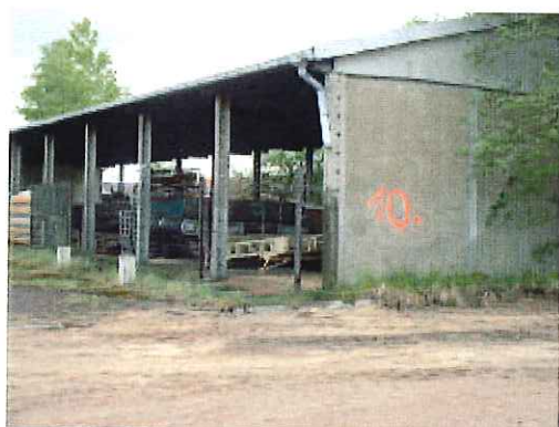
Gebäude 10, nicht von Rückbauarbeiten betroffen
