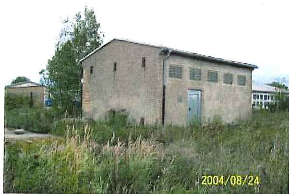
Gebäude 13 – Verwaltung, Garagen, Schuppen
